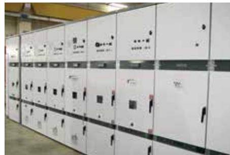
Fornitura di: Quadri di MT Miniver C ad arco interno. 6,6÷11KV - 630÷3150A - 31,5÷50KA.
