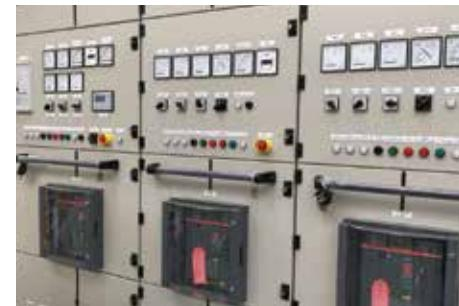
Nuova generazione di FPSO per SBM con focus sulla sicurezza totale degli impianti a bordo. Quadri BT Topside - 440V -5000A - 80kA, quadri MT Topside - 11kV-4000A-50kA.
