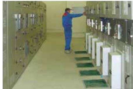
Stabilimento produttivo di elettrodomestici a Ivano-Frankivsk in Ucraina. Quadri MT Minifluor 24KV- 630A - 16kA, quadri BT Power Center 400V- 630/5000A- 100kA, quadri di distribuzione energia, illuminazione ed alimentazione macchina.
