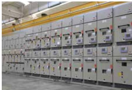
Revamping del Crane vessel con rimodernamento dei sistemi elettrici, Quadri MT blindati ad arco interno, doppio piano 11kV-4000A-50kA, quadri BT 440V-5000A-70kA.
