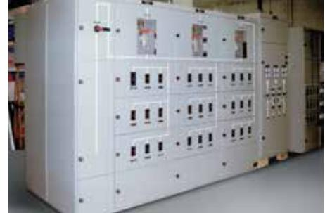
Impianto della RTN 220 kV di proprietà di Terna S.p.A. a Cardano. Quadri BT per Servizi Ausiliari QSA 400 V a 50Hz.
